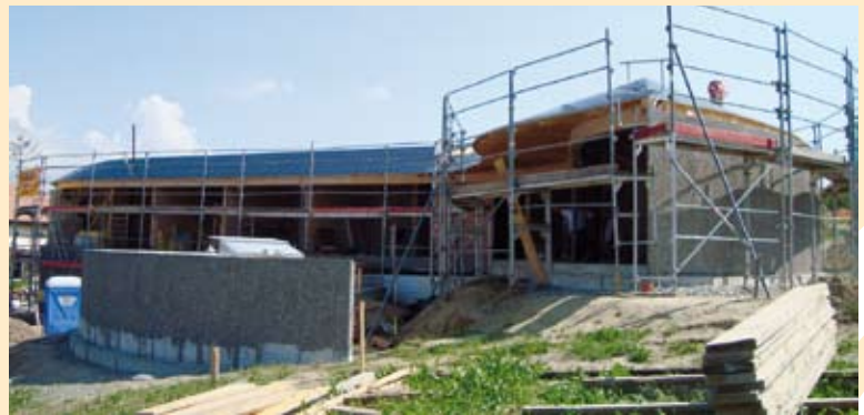
Ansicht des Rohbaus – zusammentreffen von Glasfront und der Steinfassade auf der Rückseite.
