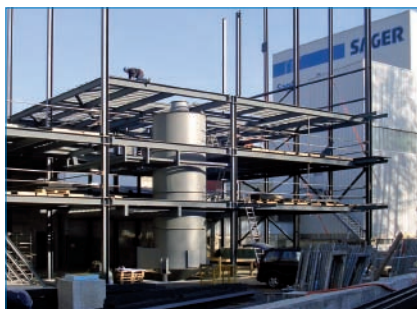
Imposante construction métallique, adossée au hall de production – les plates-formes du nouveau bâtiment du four PIPELANE.
