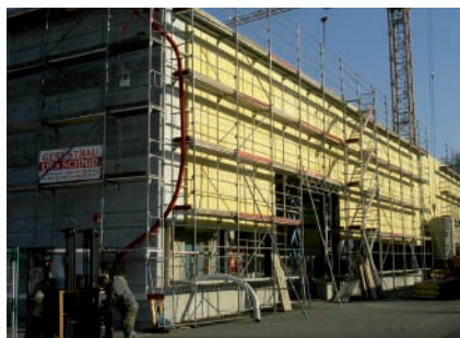
Le nouveau hall de production Sager des coquilles PIPELANE, isolé avec des panneaux pour cassettes SAGLAN SK.
