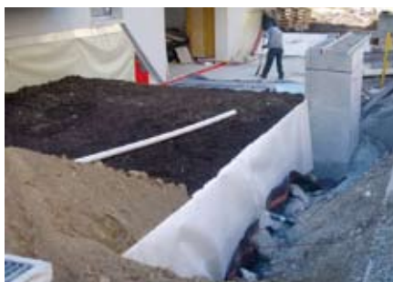
Couverture des blocs avec un voile de protection (aussi latéralement), ballast et humus.
