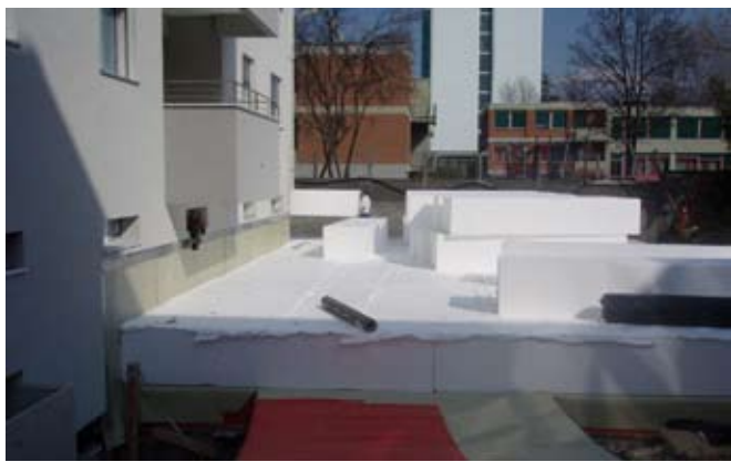
Déchargement des blocs bruts en SAGEX EPS pour le plafond du garage recouvert d'une feuille de Sarnafil étanche à l'eau.
