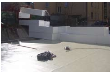
Déchargement des blocs bruts en SAGEX EPS pour le plafond du garage recouvert d'une feuille de Sarnafil étanche à l'eau.
