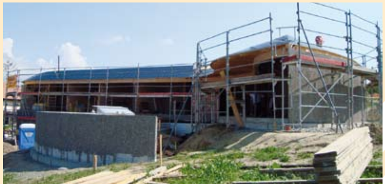
Vue du gros œuvre – joint du front vitré et de la façade de pierre à l'arrière.
