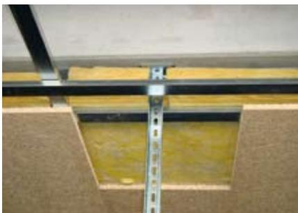
Plafond isolé avec solive en béton et construction de retenue. Au-dessus des panneaux isolants SAGLAN, on fixe à l'aide de vis des panneaux de particules en laine de bois liés à la magnésie. Finalement, le plafond est encore aspergé de peinture blanche.
