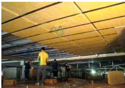
L'équipe montage en train de poser les panneaux plafonniers et isolants SAGLAN. Les différents matériaux et la masse volumique apparente des panneaux et les couches d'air intermédiaires entre les éléments du plafond en béton et l'isolation assurent dans le garage souterrain un chauffage idéal de l'étage supérieur et une acoustique optimale.
