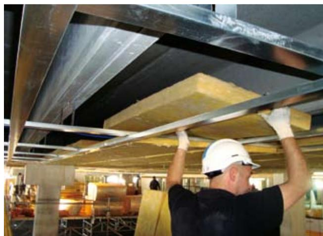
Sous le plafond en béton est monté un plafond suspendu. Les panneaux isolants SAGLAN FA 40 avec battues sont insérés dans cette structure permettant ainsi d'éviter un pont thermique.
