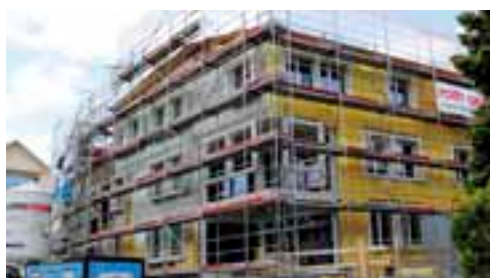
Construction en béton composée de panneaux isolants SAGLAN (032) FA 40 posés sur toute la surface à joint serrés.
