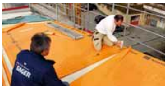
Raccordement et collage du lé de recouvrement Ampatop Seal au moyen d'un solvant Liqui Seal et pinceau.
