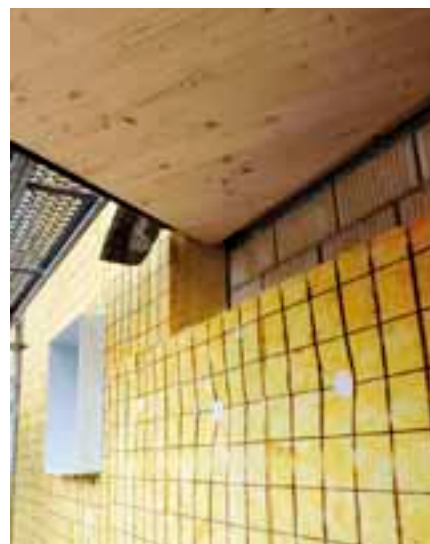
Entrée «Gürberhaus» – isolation des parois par panneaux de façade isolants SAGLAN (032) FA 40
