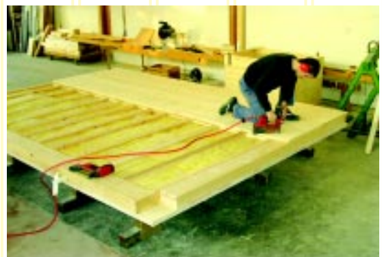
Saglan-Gold SR 22 im Sandwich, abgedeckt mit 3-Schichtplatten und Fermacell.
