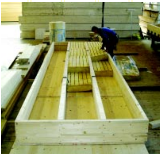
Dachelement, gefüllt mit 2 x 180 mm dicken Saglan-Gold SR 22 Platten.
