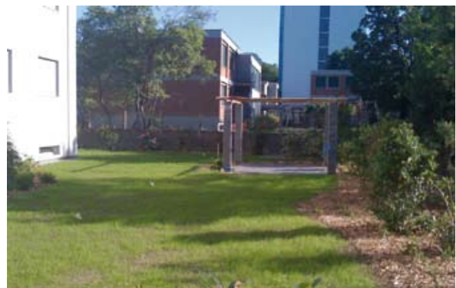
Ein perfekt von unten „gedämmter“ Garten mit bereits wachsendem Rasen und Sitzplatz mit Pergola. Die Überdeckung mit Erdmaterial sollte mind. 50 cm betragen. Nicht nur im Garten- und Landschaftsbau, sondern auch im Strassen-, Gelände- und Böschungsbau wird SAGEX schon seit Jahren erfolgreich eingesetzt.
