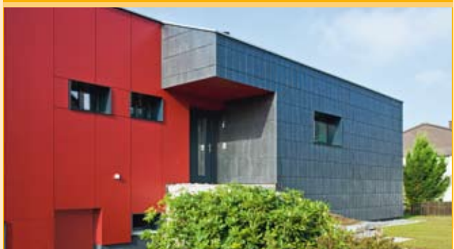
Villa 2010 optimalement isolée, MINERGIE-P
