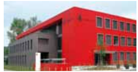
MINERGIE-P-ECO – Vogelwarte Sempach gedämmt mit SAGLAN Glaswolle
