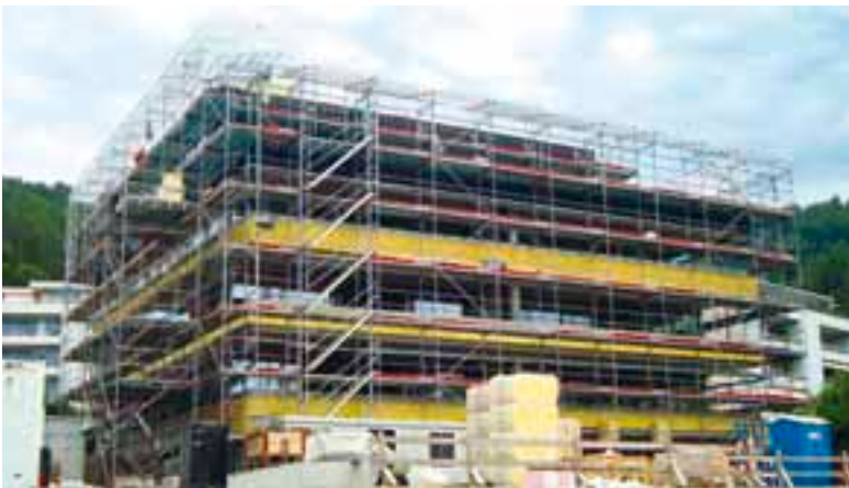
MFH Kubus mit «SAGLAN Dämmstoffbändern» während der Bauphase.
