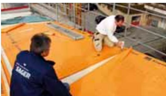
Verlegung der Ampatop Seal Abdeckbahn mittels Liqui Seal Quellschweissmittel und Pinsel.
