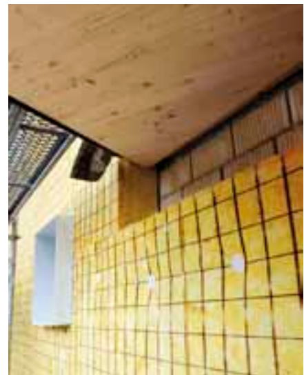
Eingang "Gürberhaus" – Wanddämmung mit SAGLAN (032) FA 40 Fassaden-Dämmplatten.
