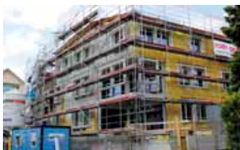
Betonbau mit vollflächig, satt und fugenlos verlegten SAGLAN (032) FA 40 Dämmplatten.
