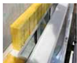
SAGLAN Zuschnitte – ideal zum Ausdämmen der Storenkästen und Fensterstahlzargen.
